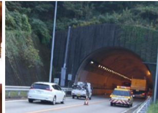
平成 19 年 10 月 24 日東海北陸道での試験の状況
